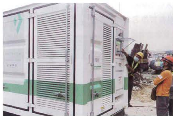
地盤施工期間以充電式淨能櫃發電，取代傳統化石燃料發電機。(圖片由被訪者提供)
