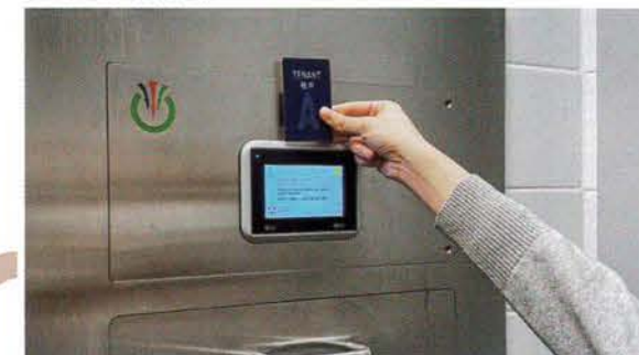
智能廢物分類管理系統可處理四類廢物，並提供即時數據。 (圖片由被訪者提供)
