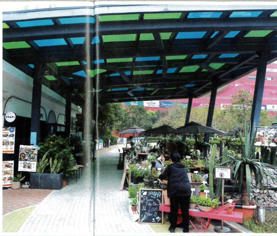
葉頌文介紹，位於零碳天地園區咖啡室外的玻璃天幕，其實是納米淨化透光太陽能板，除可以隔熱及發電，納米塗層亦可淨化空氣，該設計近年已用於大廈的玻璃窗。
