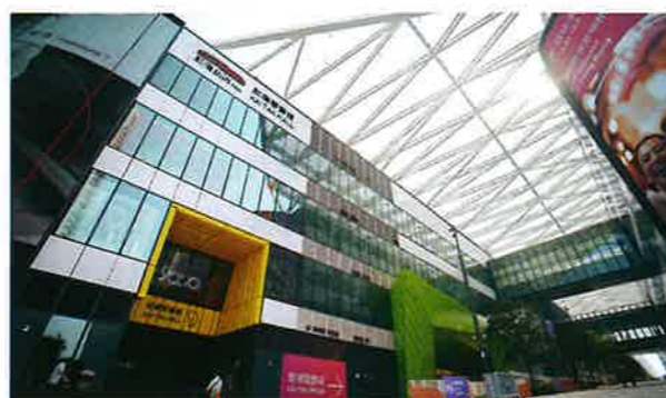
體育大道的上蓋使用吹氣膠膜，具有透光效果，能夠阻隔紫外光及噪音。(圖片由被訪者提供)
