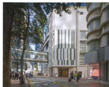
利園區的建築物透過有蓋天橋連接起來。（圖片由被訪者提供）
